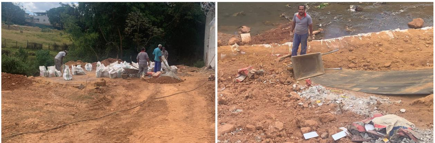
Figura 12. Ações sobre as margens do curso d'água e a contenção elaborada sem autorização na interface talude – córrego.
